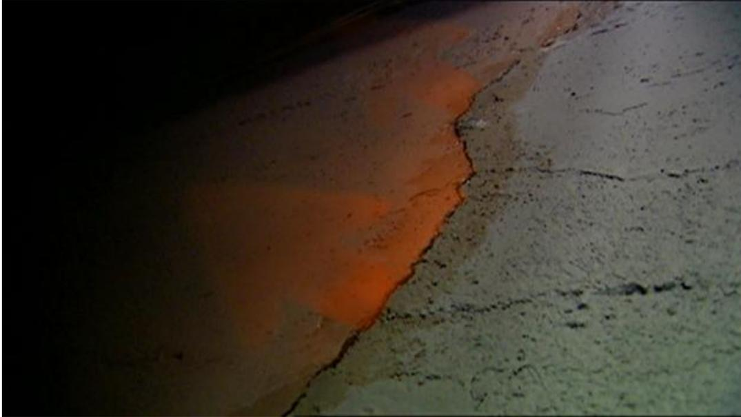
Illustration du radon qui s'infiltré par les fissures d'une fondation.
